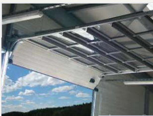
Vue d'ensemble de l'intérieur de la porte
