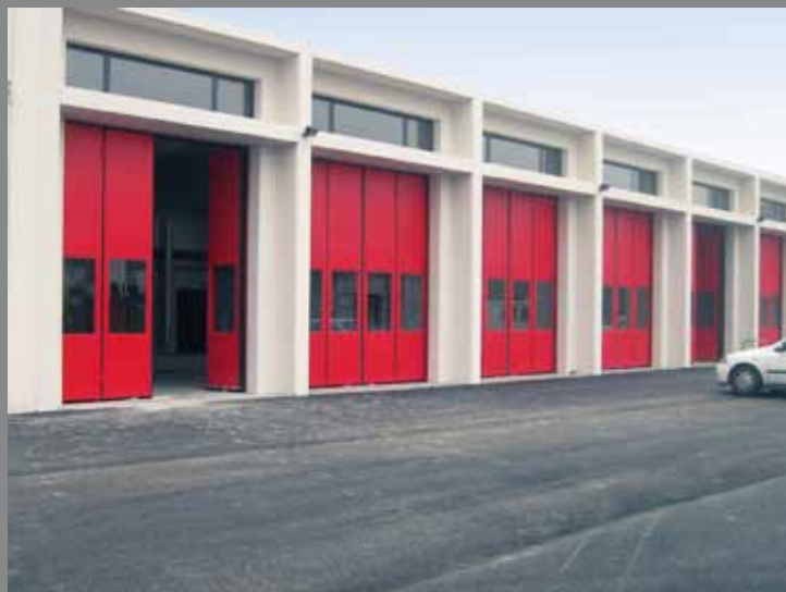
Centre de secours de St-Souplets (77)
