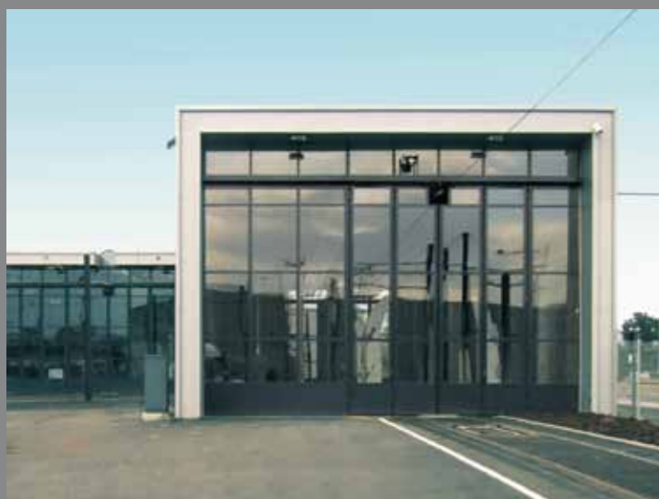
Dépôt Tramway de Mulhouse (68)
