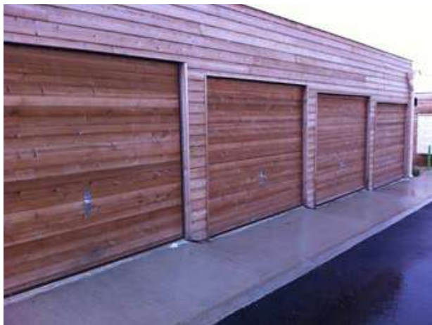
▲ Portes P50W remplissage lames horizontales option personne à mobilité réduite, finition peinture thermolaquée
