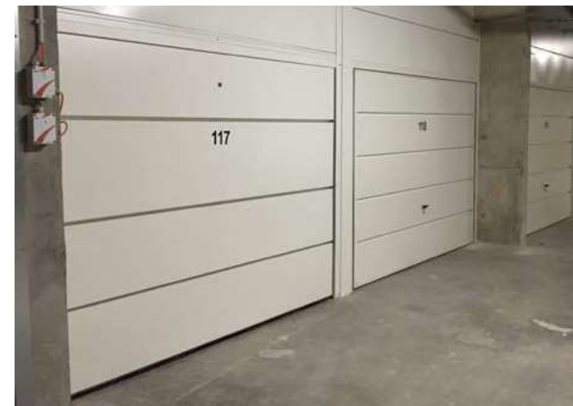
▲ Portes P50W remplissage panneaux jointés et finition peinture thermolaquée
